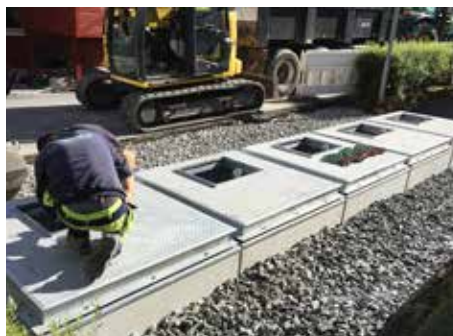
Grov pukk fylles rundt stålcontainerene.
