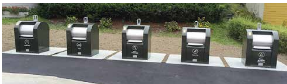
Kapasiteten på denne installasjonen kan dekke opptil 35 boenheter. Her er det satt ned tre 5m 3 containere til restavfall, papir og plastemballasje og to 3m 3 containere til matavfall og glass/metallemballasje. Sklisikker gulvplate/plattform rundt innkastsøylen. Bilde til høyre: Slik tømmes containerne av renovatøren. Beholderen løftes med kran til renovasjonsbilen. Bunnen av beholderen åpnes og avfallet tømmes enkelt ned i renovasjonsbilen.
