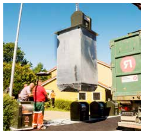
Innkastsøylen i galvanisert stål settes på plass.
