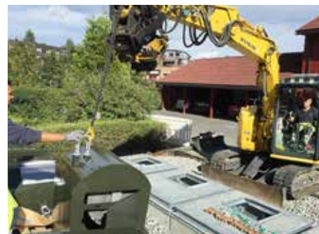
Innkastsøylen i galvanisert stål settes på plass.
