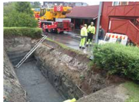
Til fem containere ble det gravd et hull på ca.: Bredde 2,2 m x lengde 9 m.
