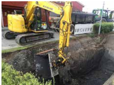
Innstallasjonsdybden på BWaste Lumio er 2940 mm.
