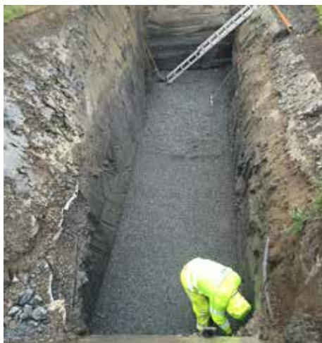
Stabiliseringsgrus fylles opp i bunn.
